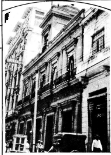
CIENFUEGOS.—El nuevo edificio de Correos y Telégrafos de esta ciudad. (Fotos B. Alvarez).
