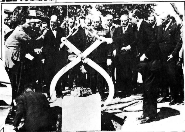
LA COOPERATIVA DE CASAS BARATAS DE SEVILLA .—Don ALFONSO XIII colocando la primera piedra de uno de los edificios que está construyendo la Cooperativa de Casas Baratas de Sevilla, con objeto de proporcionar alojamiento confortable y económico a las familias obreras.
